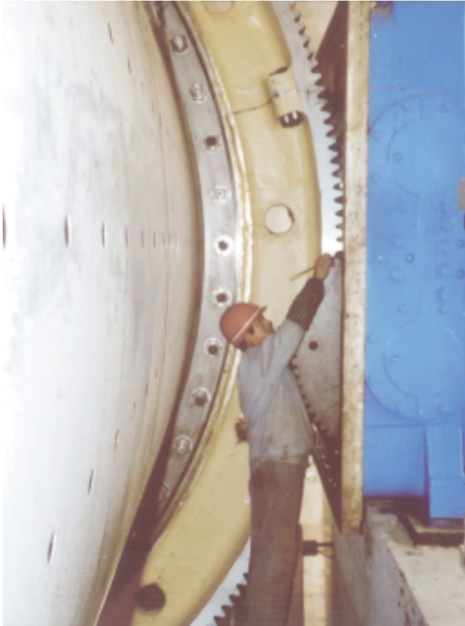
Abb.8: Montage eines Antriebes
