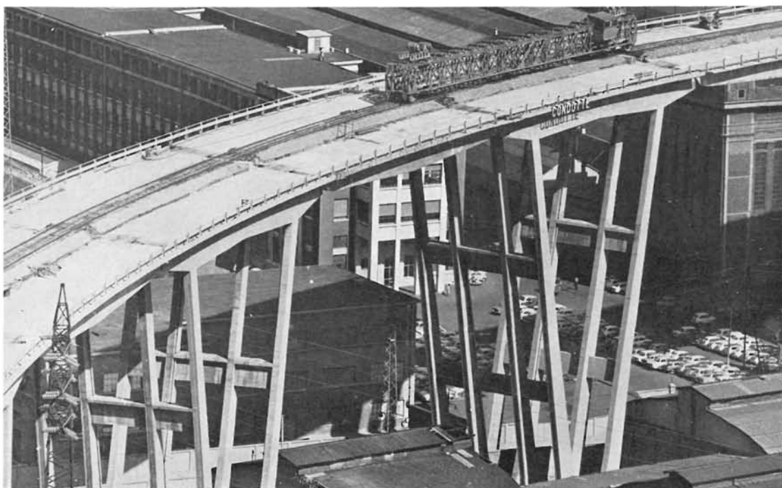
Lanzamiento de las vigas entre las pilas números 7 y 8.
