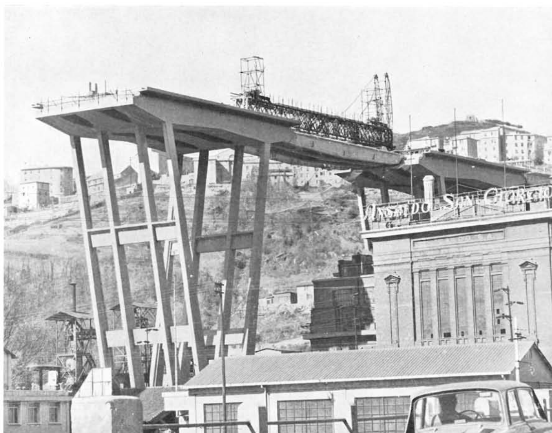
Lanzamiento de las vigas entre las pilas números 2 y 3.
