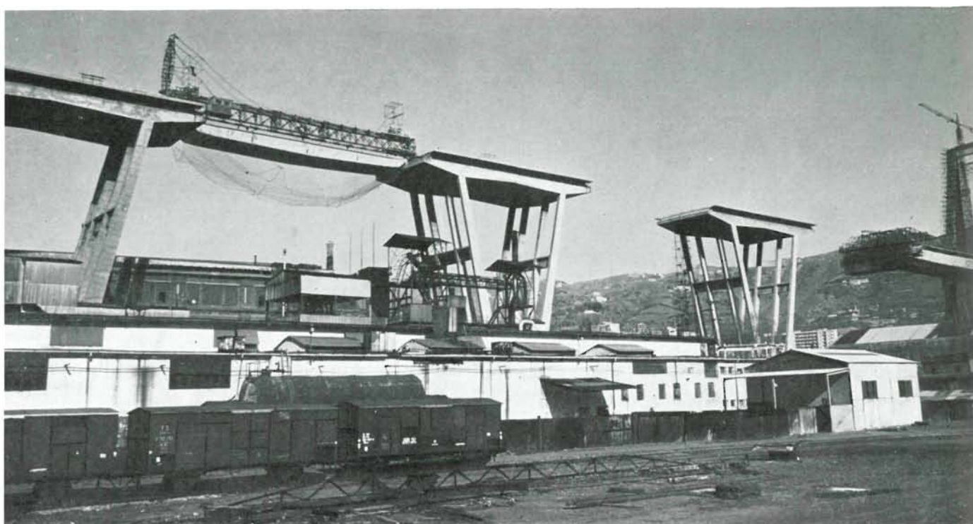
Lanzamiento de las vigas entre las pilas números 6 y 7.
