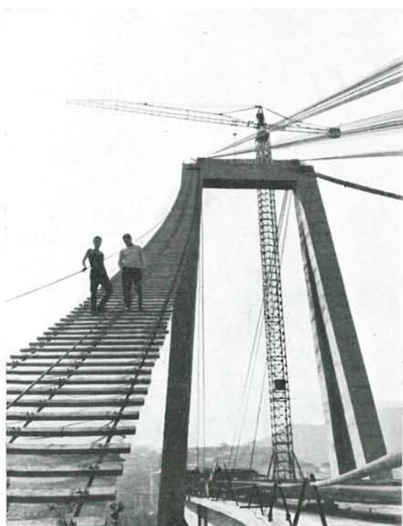
Pasarela de servicio para el montaje de los tirantes.
