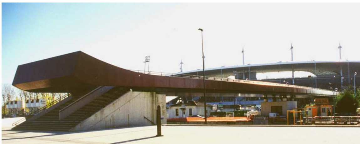
Photograph 4.2 – Stade de France footbridge
