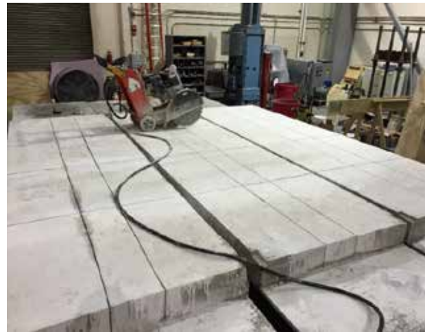
(d) Decks after Saw-Cutting
