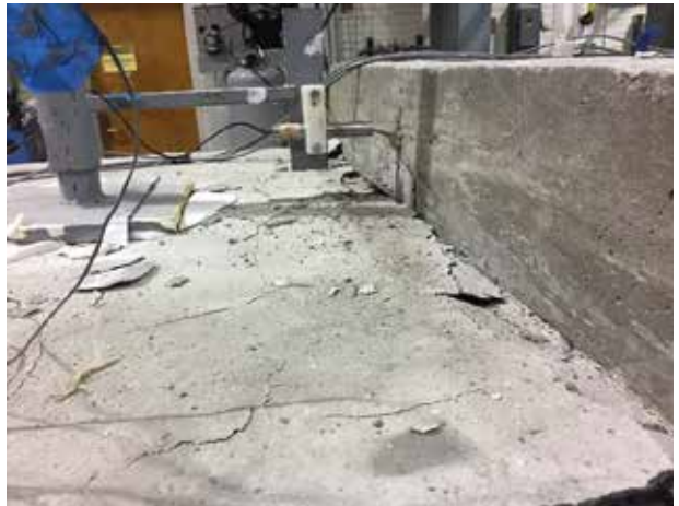
(d) Girder Top Flange Cracking after Failure
