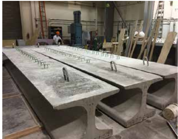
(d) After Deck Removal
